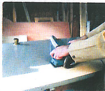
Décapage d'une surface plane.
