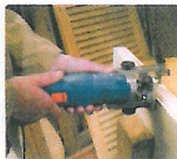
Réalisation de moulures.
